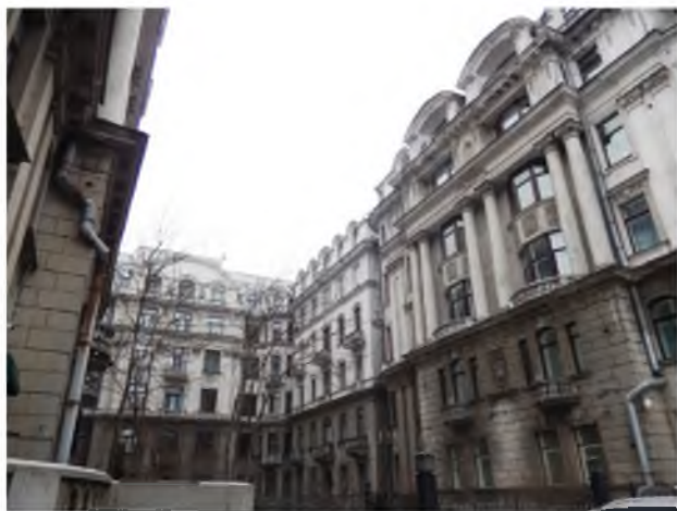
Фото 5 – Жилой кооперативный дом по адресу Каменноостровский пр., 73-75 – ул. Академика Павлова (ранее Лопухинская улица), 16, в котором архитектор И.И. Яковлев жил со своей семьей
